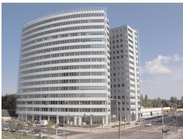
LCN-Gebäudesteuerung im Eurotower Budapest
